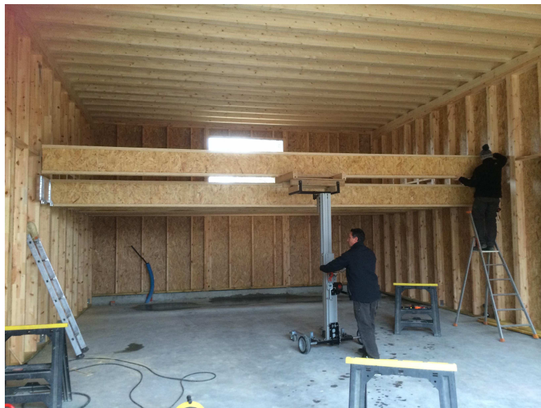
BD 1 mit wood beam 180 kg - 7 m Length
